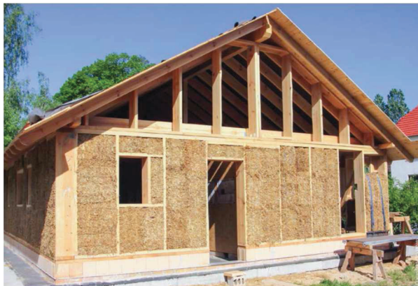
Lastragende Strohbauweise
